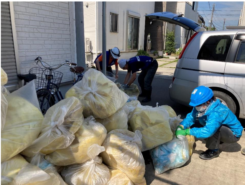
搬出した断熱材
