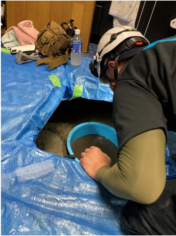
床下の水出しおよび清掃作業の様子
